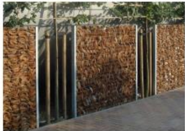
Clôtures type I en gabion
