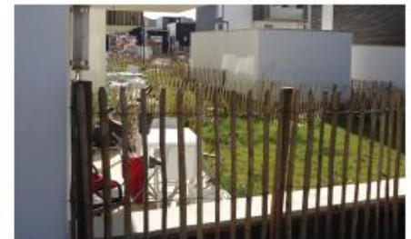
Clôtures type III ganivelles ou grillage simple maille carrée
